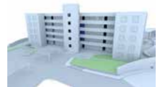
TORRE 1 • VISTA AL ESTACIONAMIENTO
