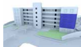
TORRE 1 • VISTA AL ESTACIONAMIENTO
