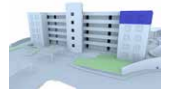
TORRE 1 • VISTA AL ESTACIONAMIENTO
